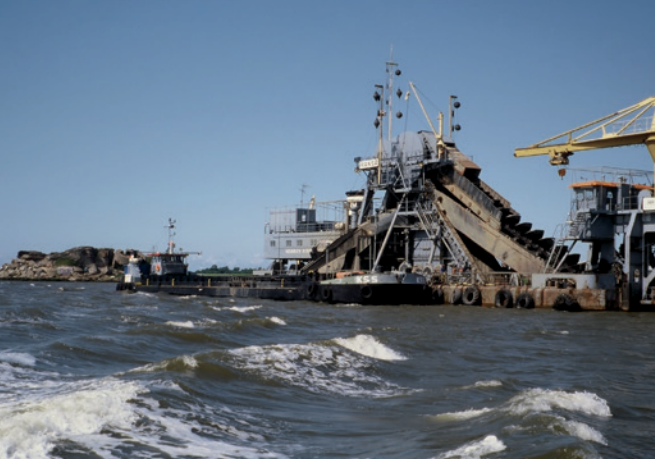
Immer schneller setzt sich die Fahrrinne zu – die Bagger sind im Dauereinsatz
